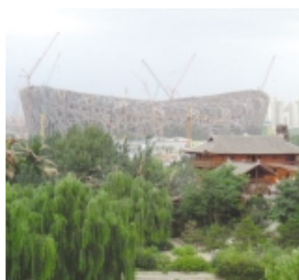
着々と建設が進む五輪会場
