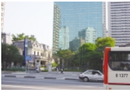
パウリスタ大通りにあるコーヒー景気の当時の建物と国際協力機構、交流基金、三井住友銀行、伊藤忠商事などが入る近代的なガラス張りの建物
